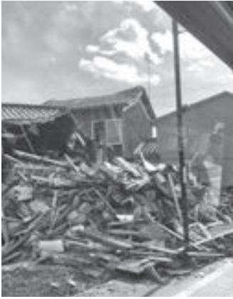
車窓から見た被災家屋
